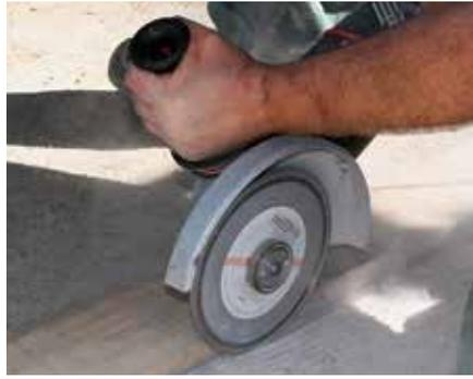
Als Abschlusskante für den zu beschichtenden Futtertisch mit der Diamantscheibe eine Begrenzungsnut von ca. 2–3 mm Tiefe einschneiden, um einen perfekten Abschluss zur Futtertenne zu erzielen. Nur vor Reinigung und Schleifen anfertigen.
