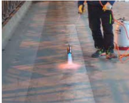
Die Fläche anschließend abflämmen und mit einem Stahlbesen sauber abkehren!
