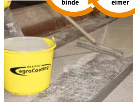
Homogenes Mischen der 2 Komponenten von **Basic**, **umfüllen** in anderen Behälter und **nochmals mischen**. (max. 300 U/min)
