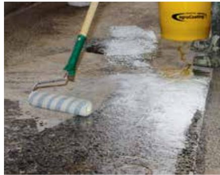
Der Untergrund ist vor der weiteren Beschichtung mit **PowerGrip** zu grundieren, damit eine optimale Haftbrücke geschaffen wird. Dazu die 2 Komponenten von **PowerGrip** homogen mischen, in frischen Behälter umfüllen, erneut mischen und anschließend mit einer Rolle auftragen. **Grundierung anziehen lassen.**
