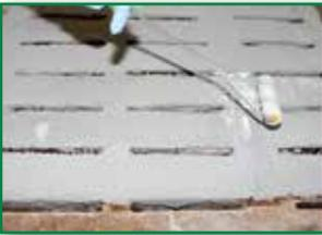
Wie unter Schritt 2 die Komponenten A und B anrühren und über die sanierten Spalten und angrenzende Bereiche ausrollen. Schützt auch neue Spalten vor Säuren.
