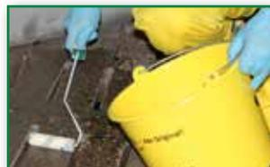
Grundierung mit einer Rolle als geschlossenen Film auftragen. Verarbeitungszeit: 10–15 Minuten
