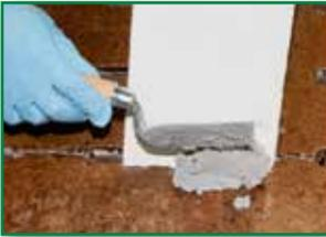
Die Masse mit einem Spachtel und einer Glättkelle verarbeiten. Bretter/Latten in Spalten stecken oder Kelle an Kanten halten. Mörtel glätten und Reste entfernen.
